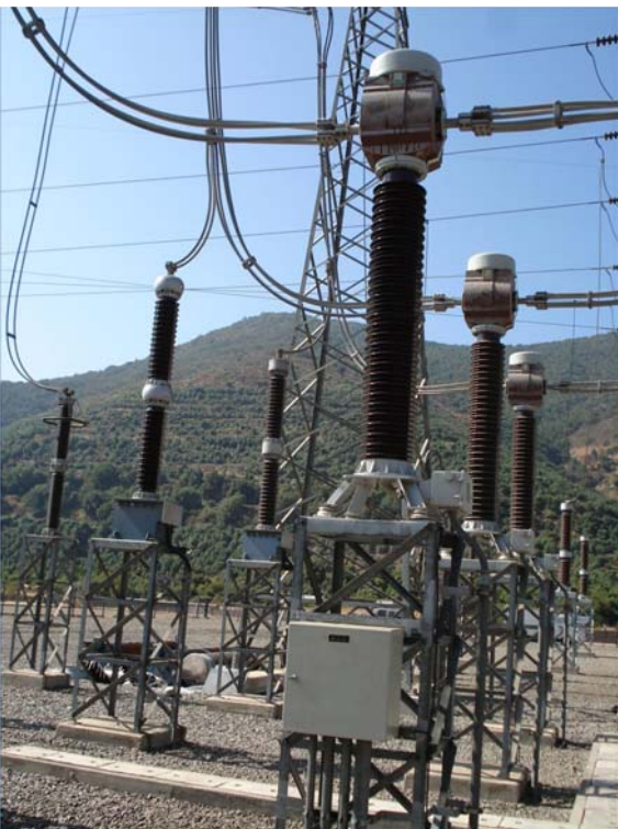
Transformadores de Corriente y Medición Current and Measuring Transformers
